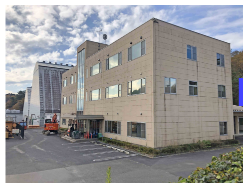
解体前の管理棟
